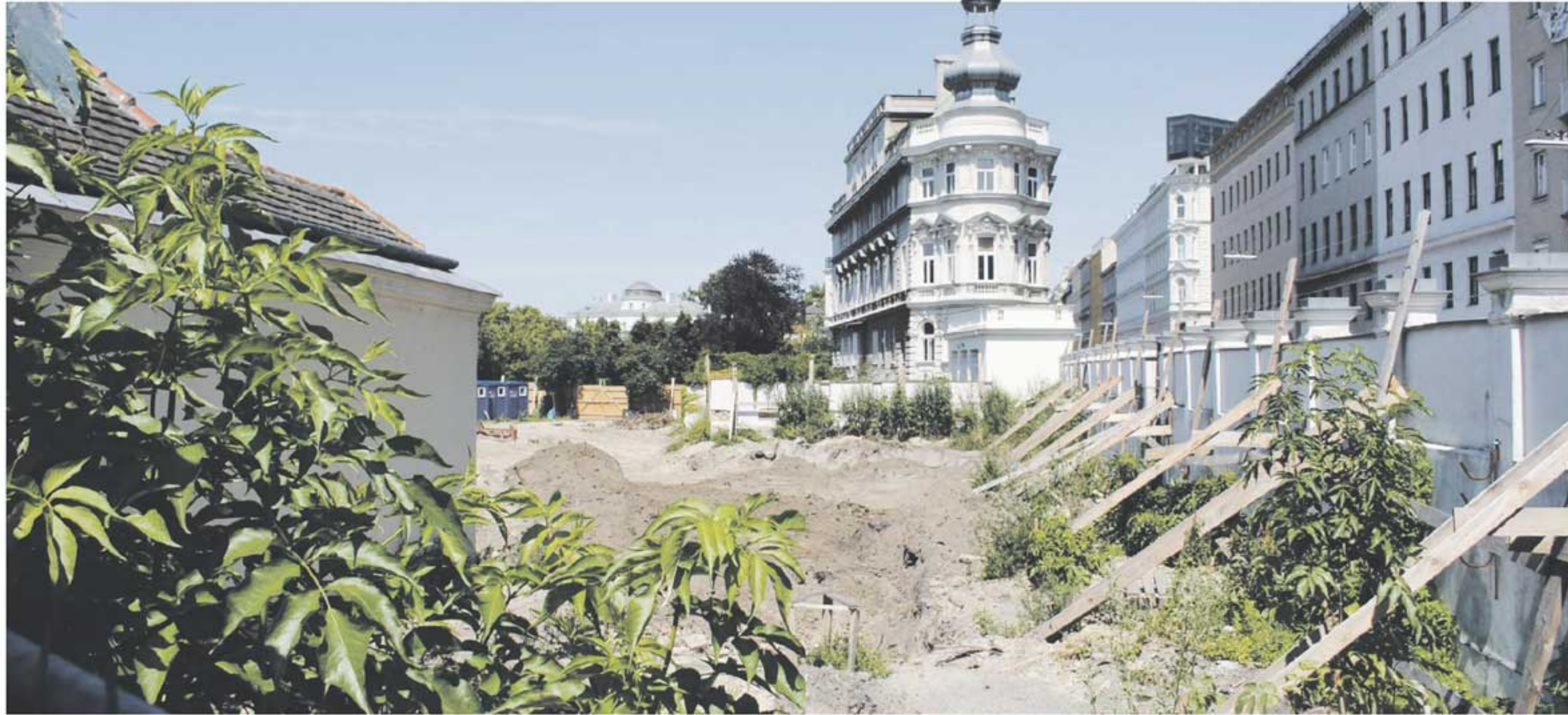
Wo früher Bäume waren, ist jetzt eine große Baugrube. Hier soll der Konzertsaal der Sängerknaben entstehen.
